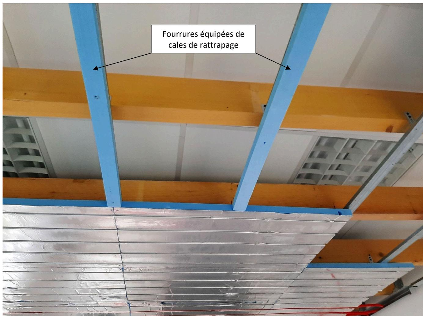
Figure 9. Mise en place des cales de rattrapages
