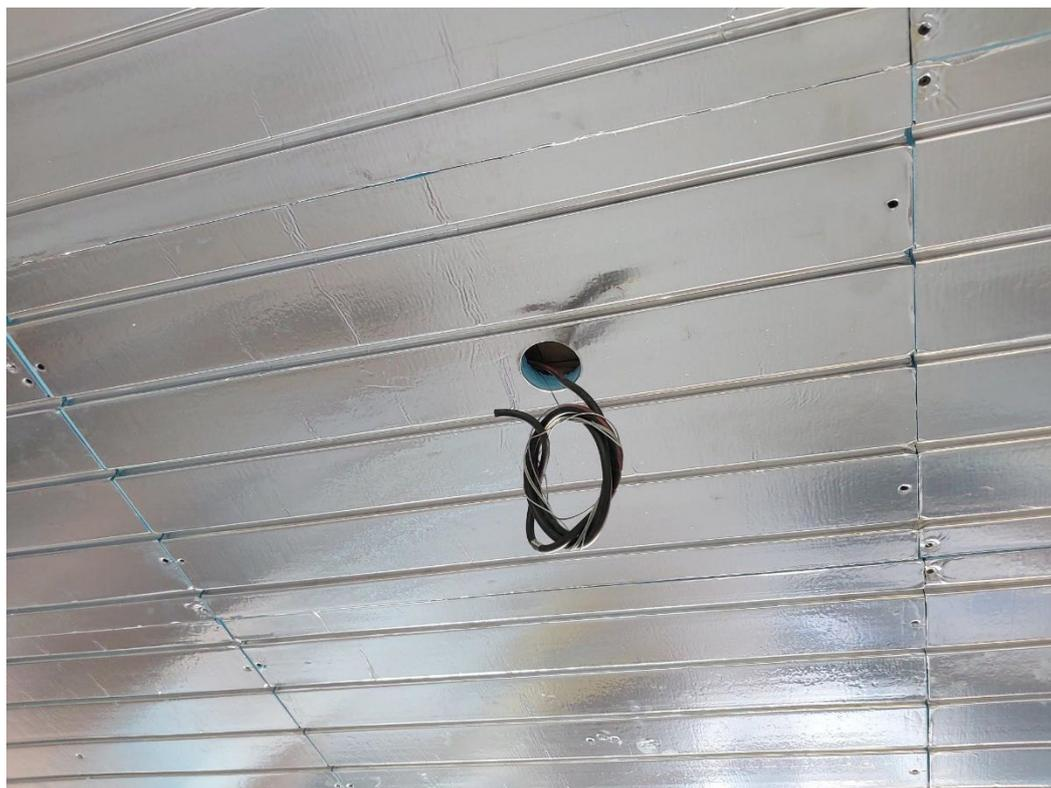
Figure 10. Passage des gaines électriques
