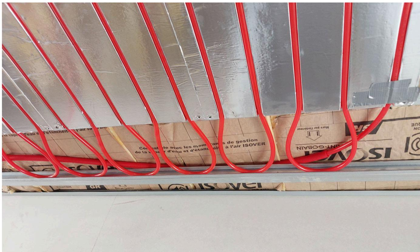
*Figure 8. Mise en place du tube dans la zone de virage*
