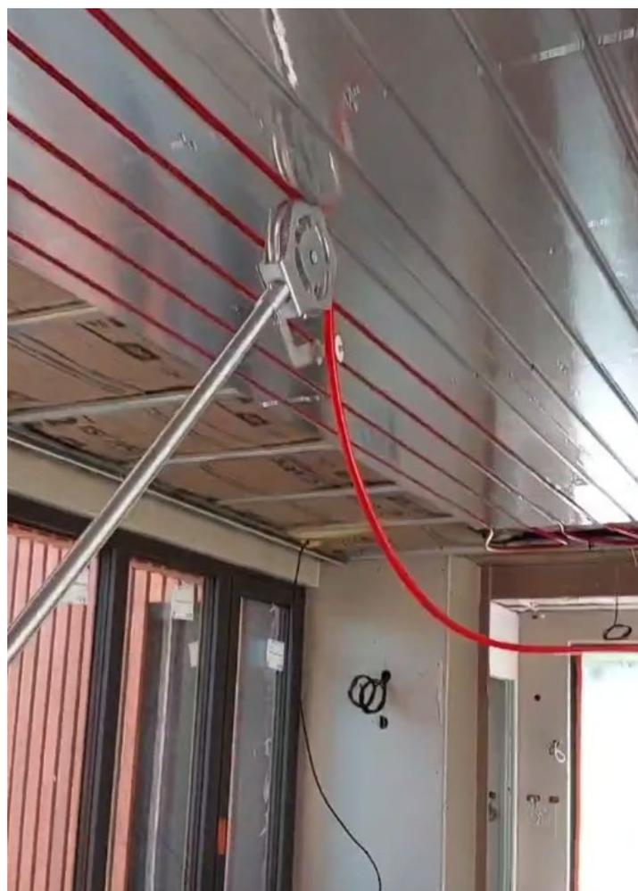
Figure 11. Pose du tube avec l'outil ROTH Easy Deck
