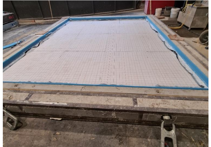
Pose de la bande latérale
