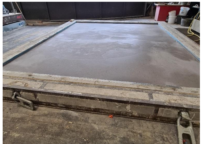
Coulage de la chape flottante
