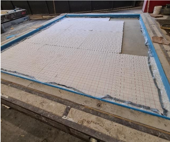
Mise en place des panneaux de laine de roche
