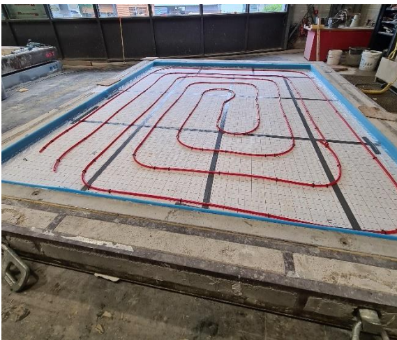
Pose du tube PE-RT
