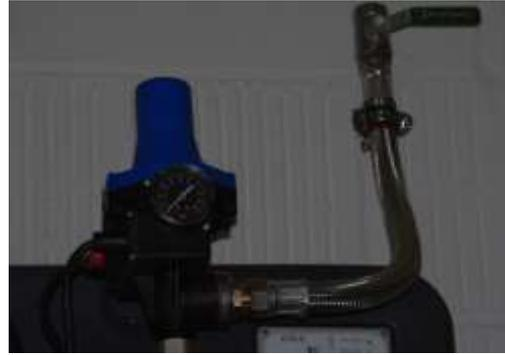
Insérer la vanne d'arrêt fourni dans le kit et raccorder ensuite la distribution.
