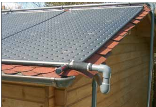
Installation sur toiture tuiles plates
