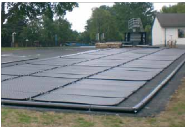
Installation sur sol libre
