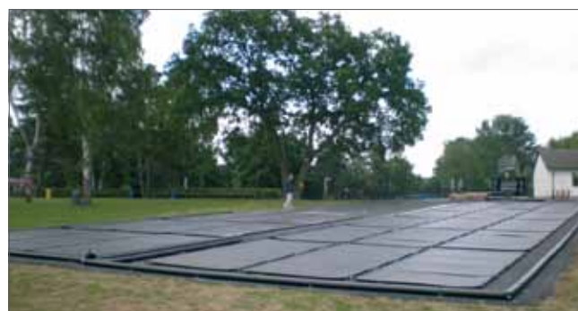
Piscine de Wehrheim (Allemagne)
