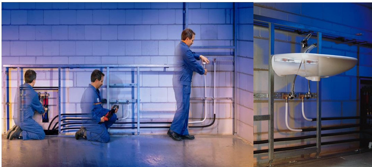
Distribution en eau potable
